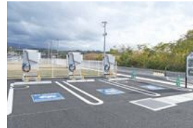
▲電気自動車の急速充電設備
